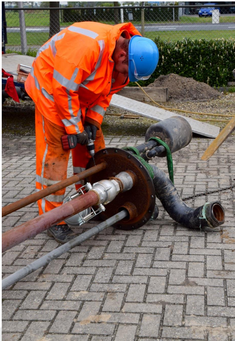
Foto: vaststellen conditie peilleiding
