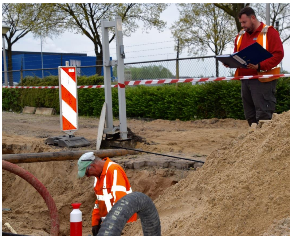
Foto: toezicht op inspectiewerkzaamheden.
